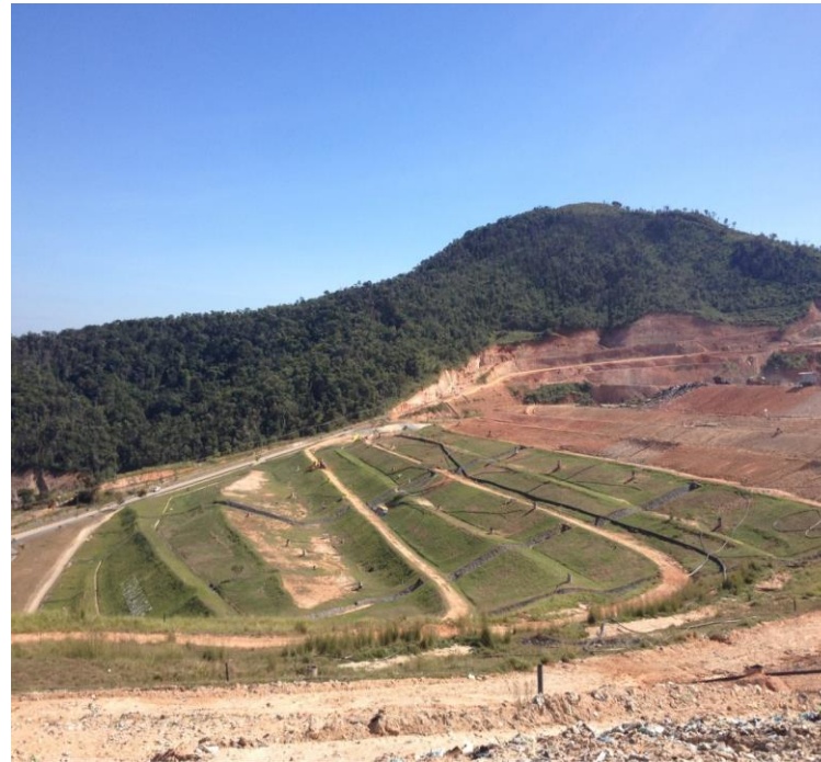
Revegetação taludes
