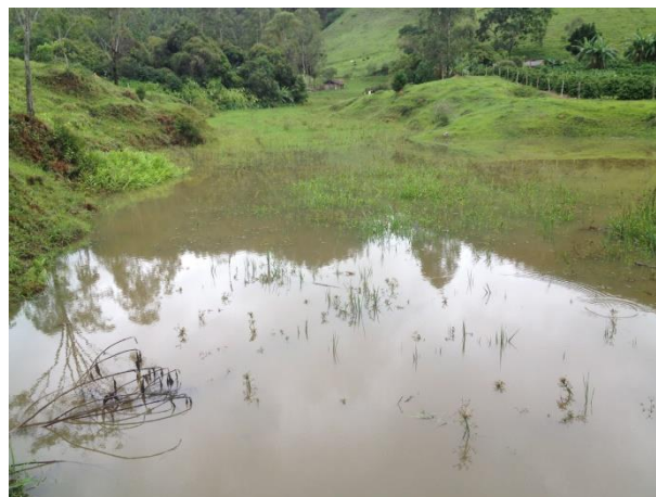
Figura 121. Imagem parcial do Ponto 2, abaixo da casa de força.
