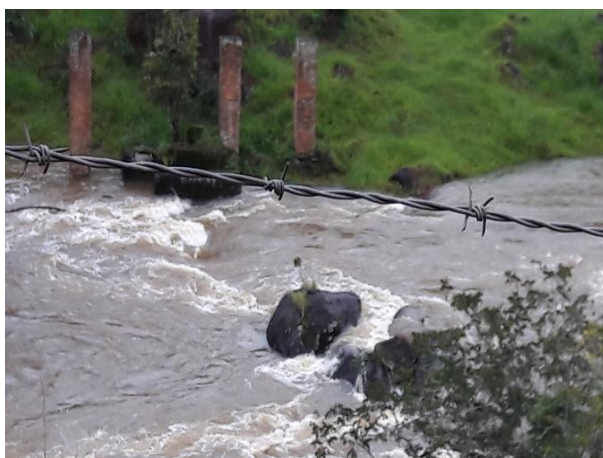
Figura 17. Zona de cisalhamento pouco abaixo da casa de força, seção representada por colapsos estruturais associados a alívio de compressão.
