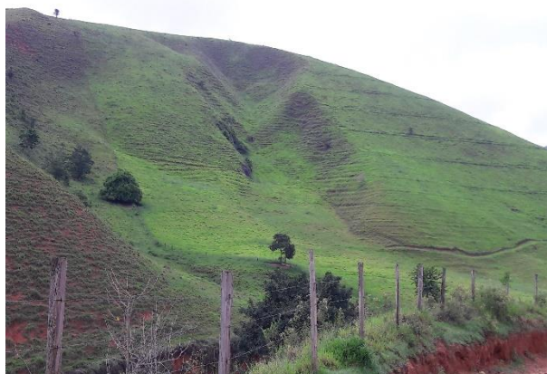
Figura 38. Evidência de deslizamento de massa cicatrizado por gramínea, no terço final da CGH Alto Glória.
