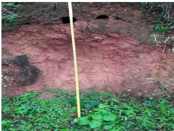
Figura 40. Perfil de Argissolo Vermelho na seção inicial da CGH Alto Glória. Vertente rompida por cisalhamento, com perfil de encosta tendendo a concavo, ocupada por pastagem.
