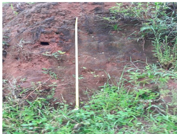
Figura 41. Perfil de Argissolo Vermelho na seção inicial da CGH Alto Glória. Vertente rompida por cisalhamento, com perfil de encosta tendendo a concavo, ocupada por pastagem.
