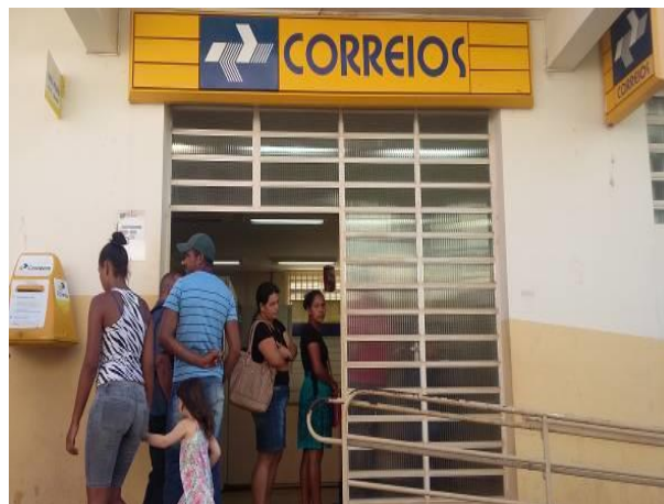
Figura 155. Correios Fervedouro - MG
