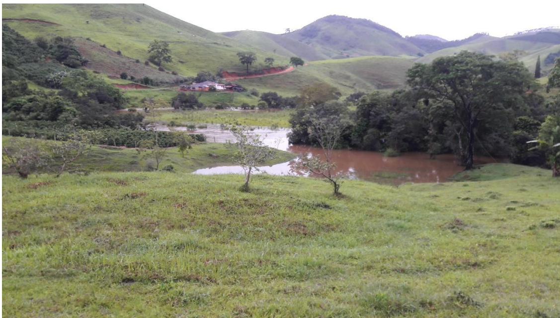
Figura 34. Estreita faixa de inundação abaixo da casa de força da CGH Alto Glória.
