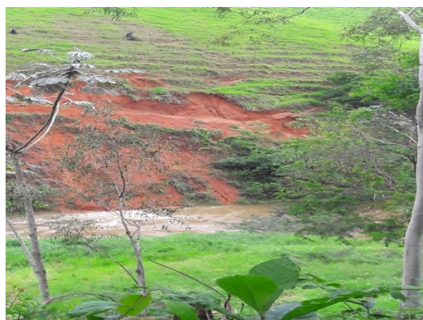
Figura 37. Deslizamentos de massa na seção final do aproveitamento, margem esquerda e direita do rio Glória. Imediações abaixo do transecto previsto para a implantação da casa de força.
